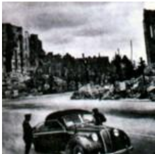
Разрушенный Берлин. Фото Д. Онохина. 1945 г.
